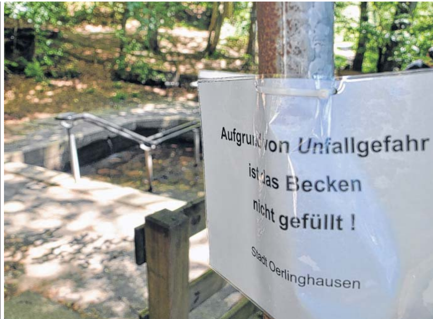
Hinweis: Dieser Zettel der Stadt weist darauf hin, dass das Wassertretbecken derzeit wegen Unfallgefahr leer bleiben muss. Wann es wieder gefüllt und die Schäden beseitigt werden können, hängt vom städtischen Haushalt ab. FOTOS: KARIN PRIGNITZ
